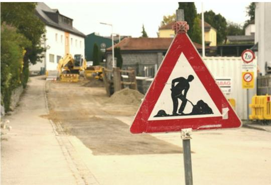
In der Kirchenstraße ist eine innenliegende Sanierung leider nicht mehr möglich. Schmutz- und Regenwasserkanal müssen zur Gänze neu errichtet werden, die Wasserleitung wird ebenfalls erneuert, alle Hausanschlüsse müssen umgelegt werden und abschließend werden Straße
